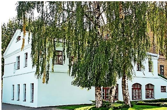
Косметический ремонт корпуса факультета экологии и ландшафтной архитектуры
