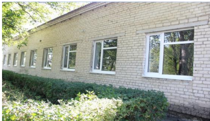
Демонтаж штукатурки и перегородок
