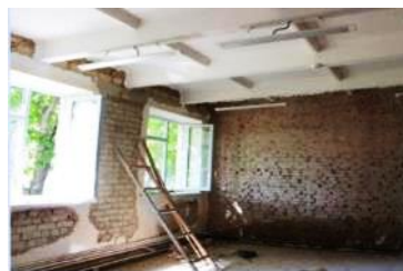
Замена оконных блоков
